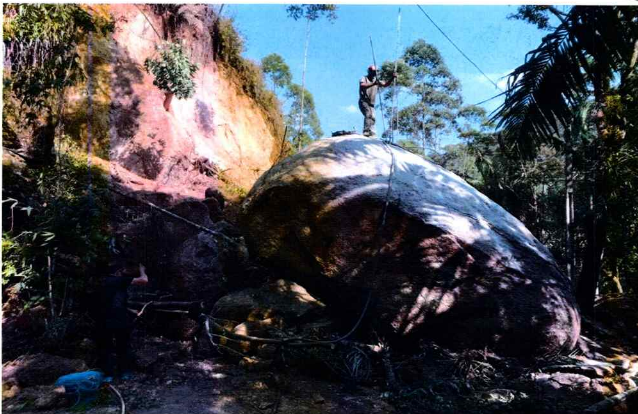
Foto 03: Vista da equipe especializada preparando o material para explodir a pedra.
