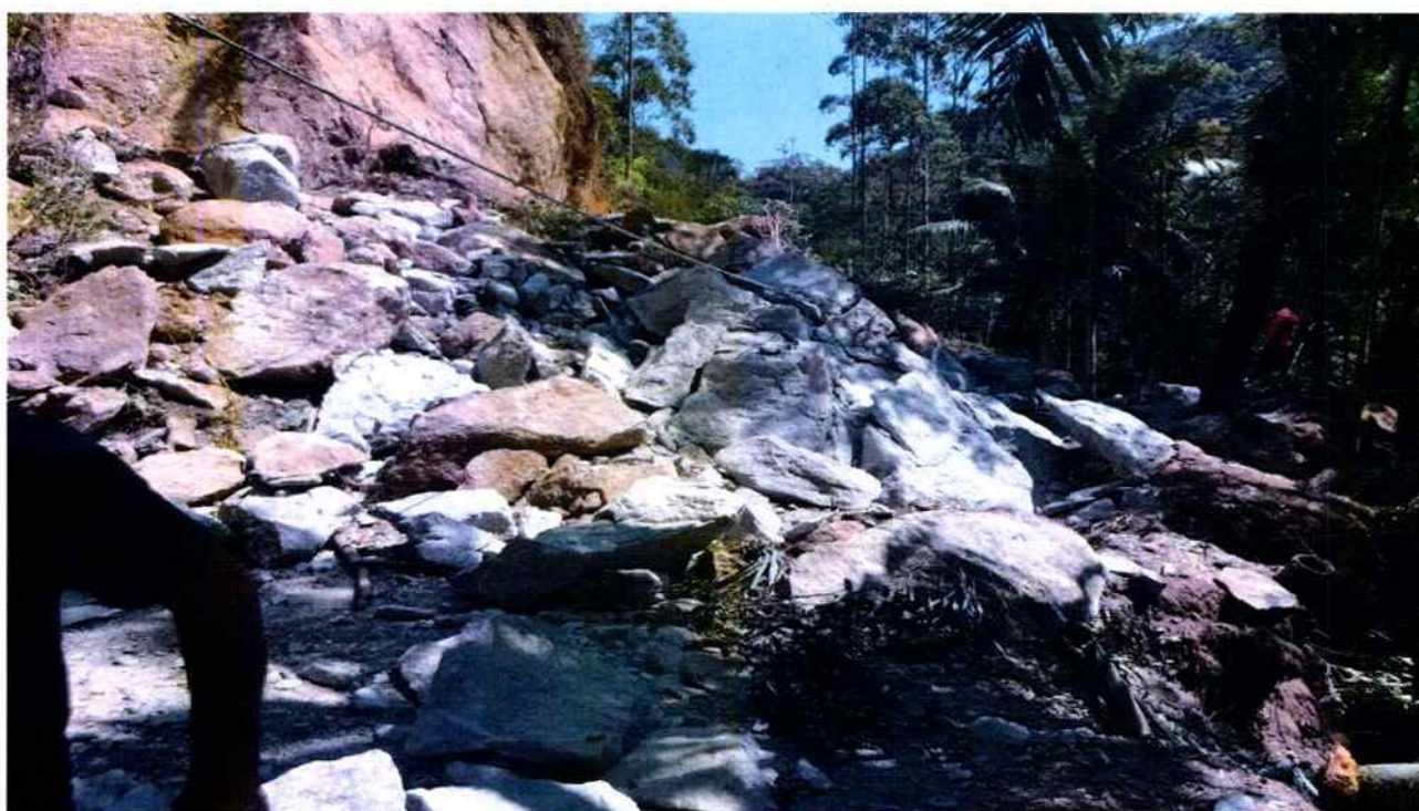
Foto 04: Vista dos destroços da pedra após a detonação.
