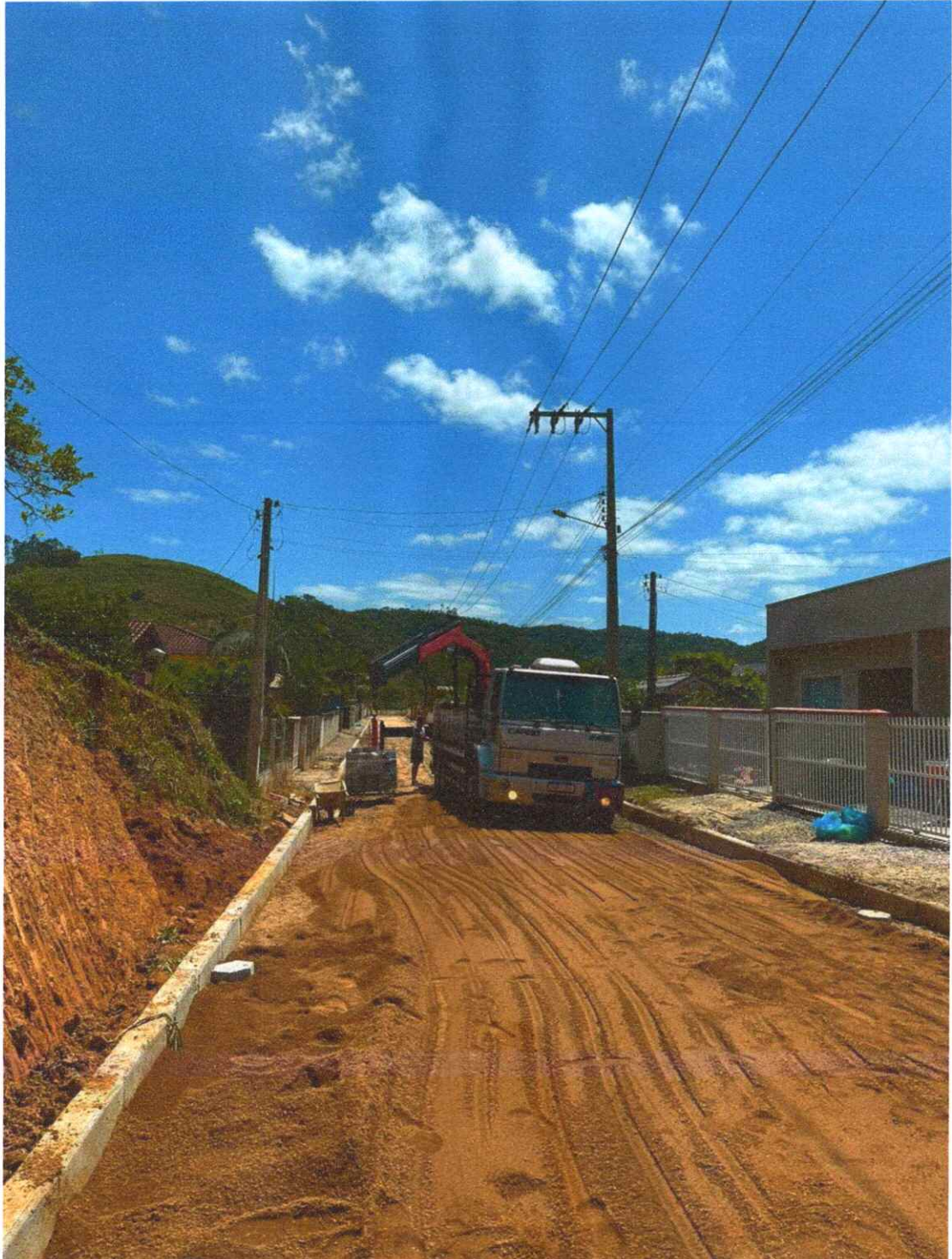
Assentamento Meio Fio.
