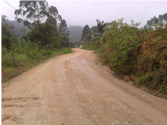
Figura 14: Vista Trecho em Rampa
