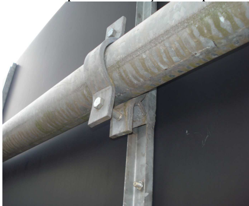
Fotografia 04 – Vista aproximada das abraçadeiras das placas modelo – D
