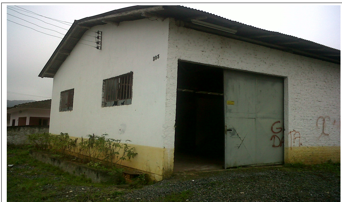
Foto 01 – Vista frontal da construção existente
