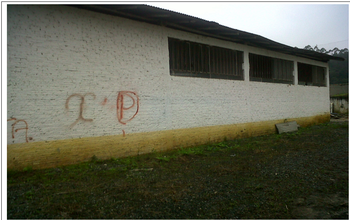
Foto 02 – Vista lateral da construção existente
