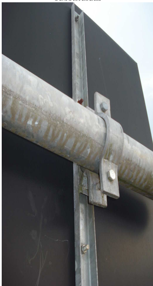
Fotografia 05 – Vista aproximada da abraçadeira das placas modelo – D – a serem substituídas
