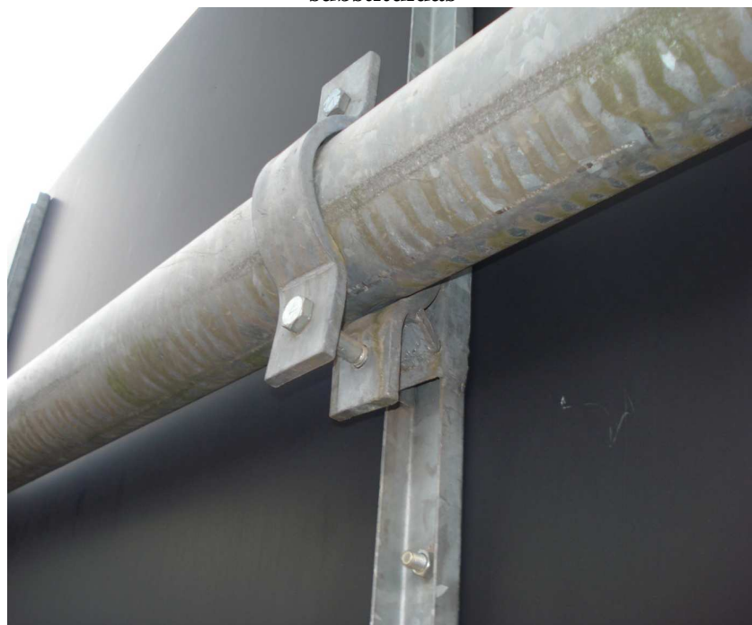
Fotografia 04 – Vista aproximada das abraçadeiras das placas modelo – D - a serem substituídas
