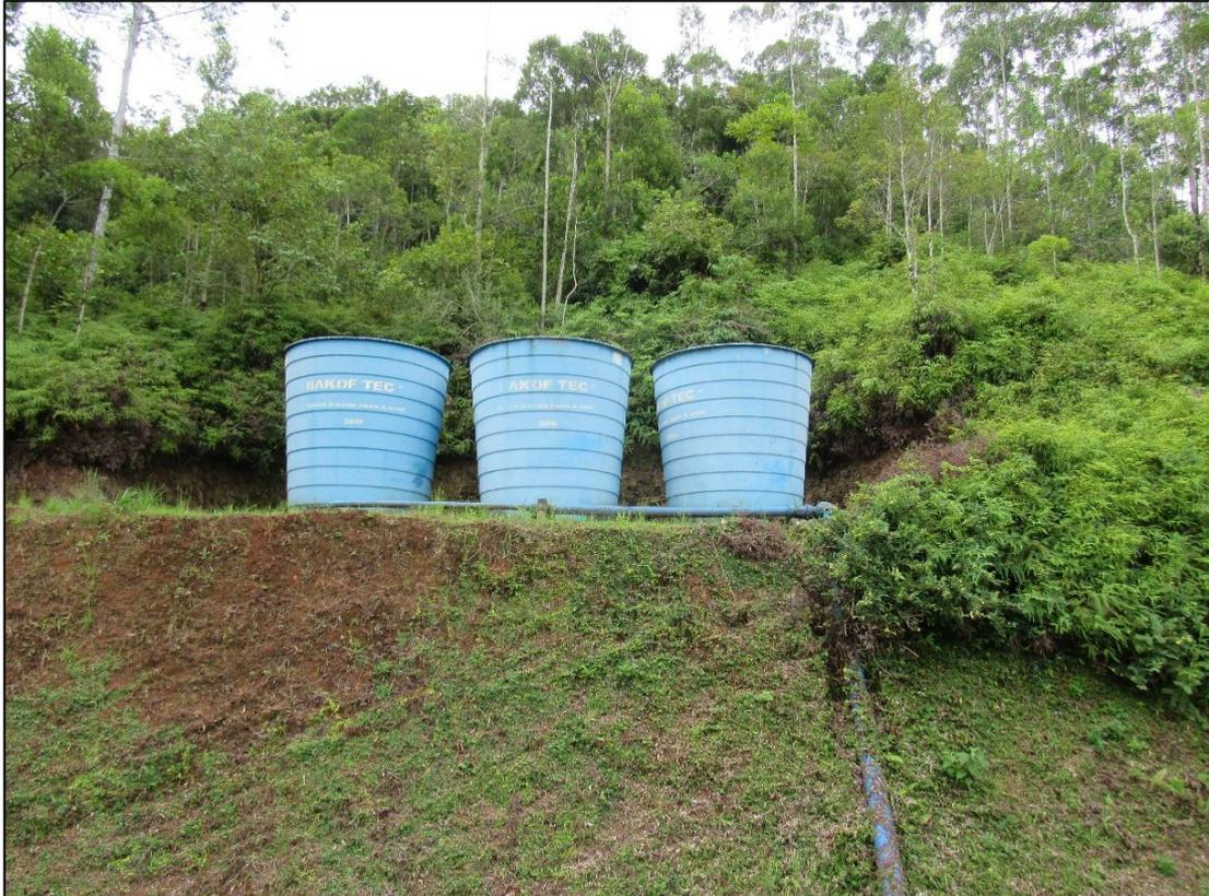
Figura 24: Sistema de filtros lentos de fluxo descendente.
