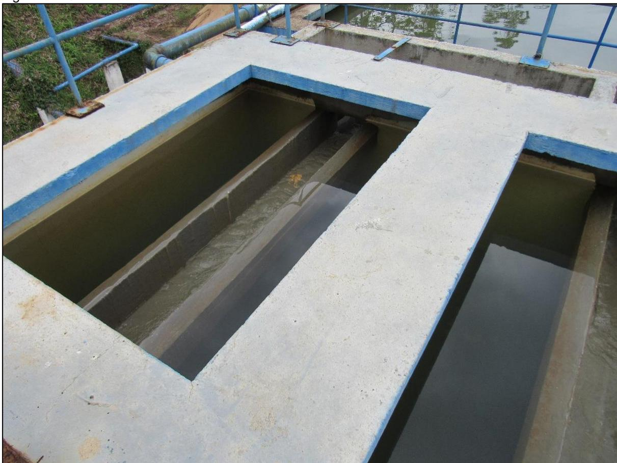
Figura 23: Reservatórios para armazenamento da água utilizada na retrolavagem dos filtros rápidos.
