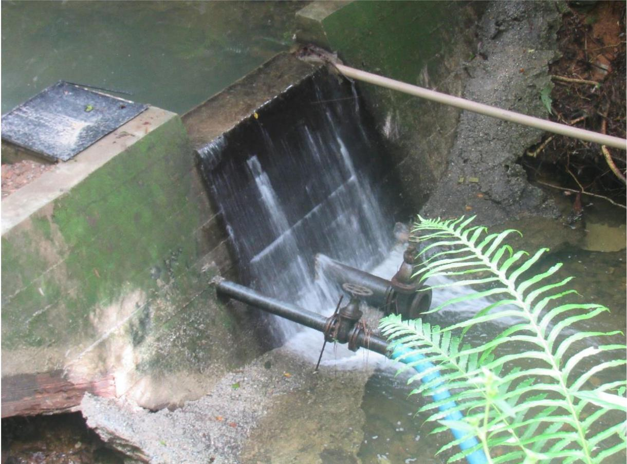
A captação 02, que funciona com uma estrutura de reforço para o abastecimento, está em cota superior à captação 01. A água captada através desse barramento é direcionada por gravidade através de tubulação de PVC DN 100 mm até o lago da barragem principal. A adução da água bruta até a ETA ocorre a partir da barragem 01, por gravidade, através de tubo de PVC DEFOFO 200 DN, com extensão de 730 metros.
