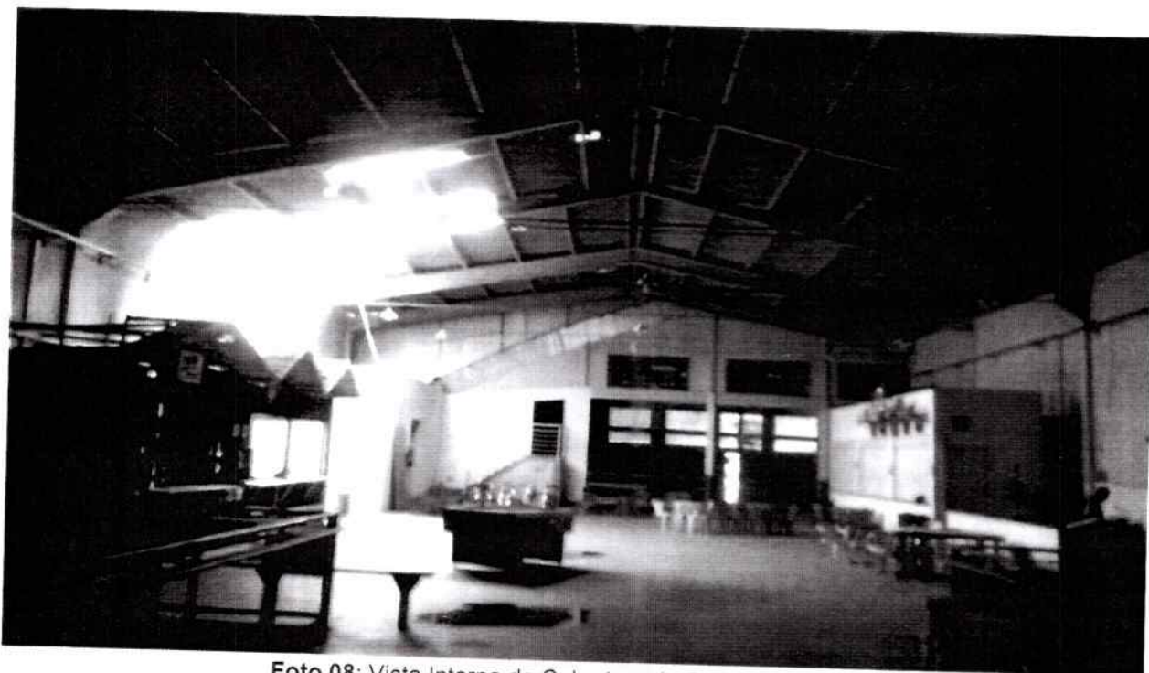
Foto 08: Vista Interna da Cobertura da Cancha de Bocha
