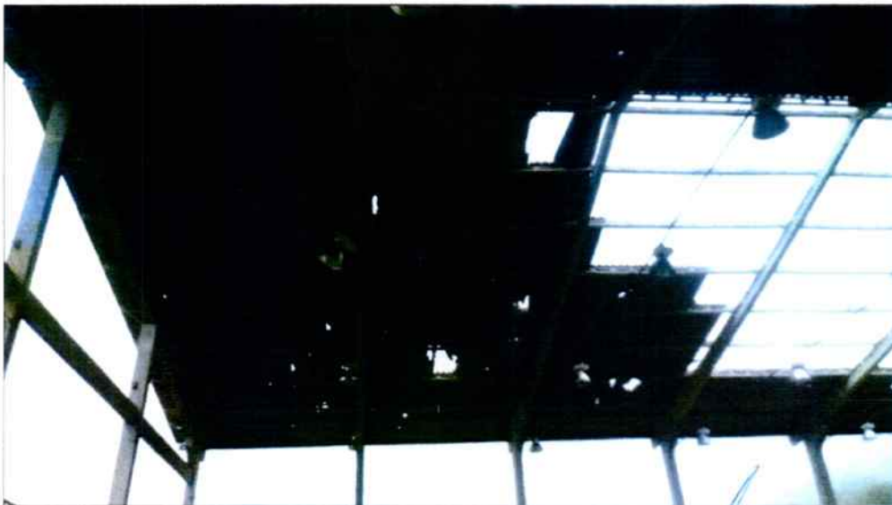
Foto 05: Vista Geral da Cobertura e das Instalações Elétricas
