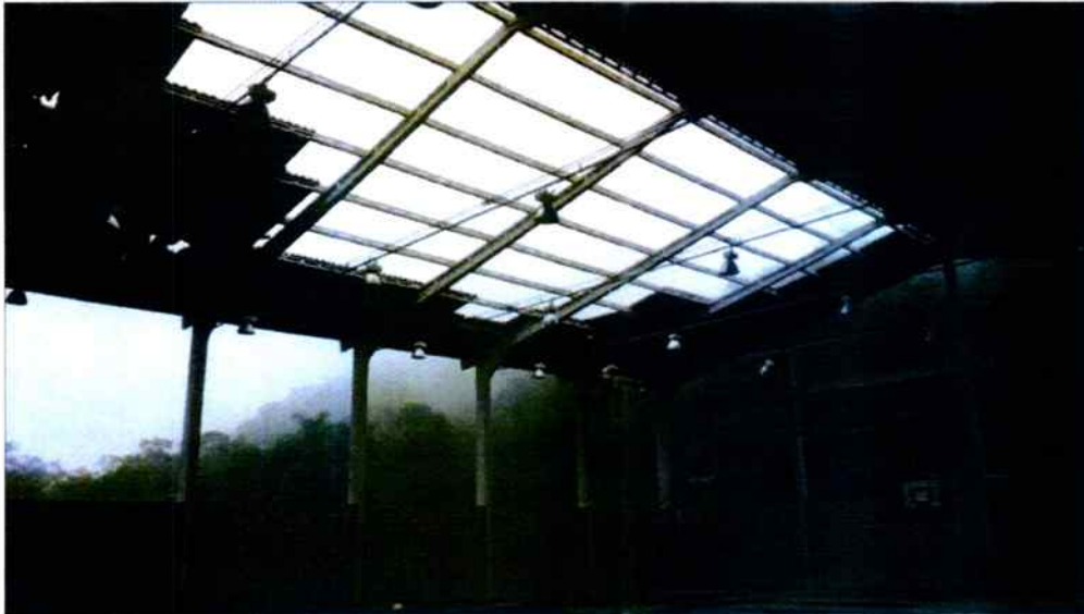
Foto 04: Vista Geral da Cobertura e das Instalações Elétricas
