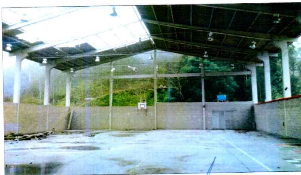
Foto 03: Vista Geral da Cobertura
