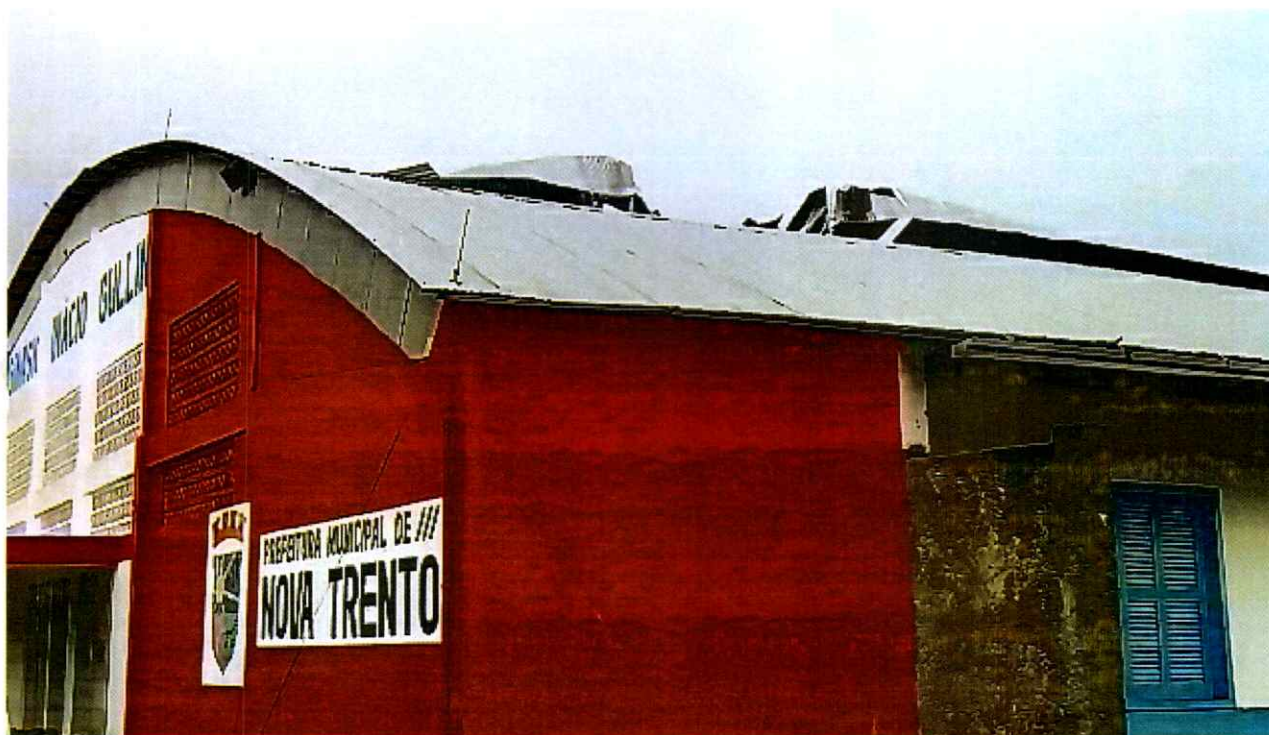
FOTO DO TELHADO DO GINÁSIO MUNICIPAL DO CENTRO
