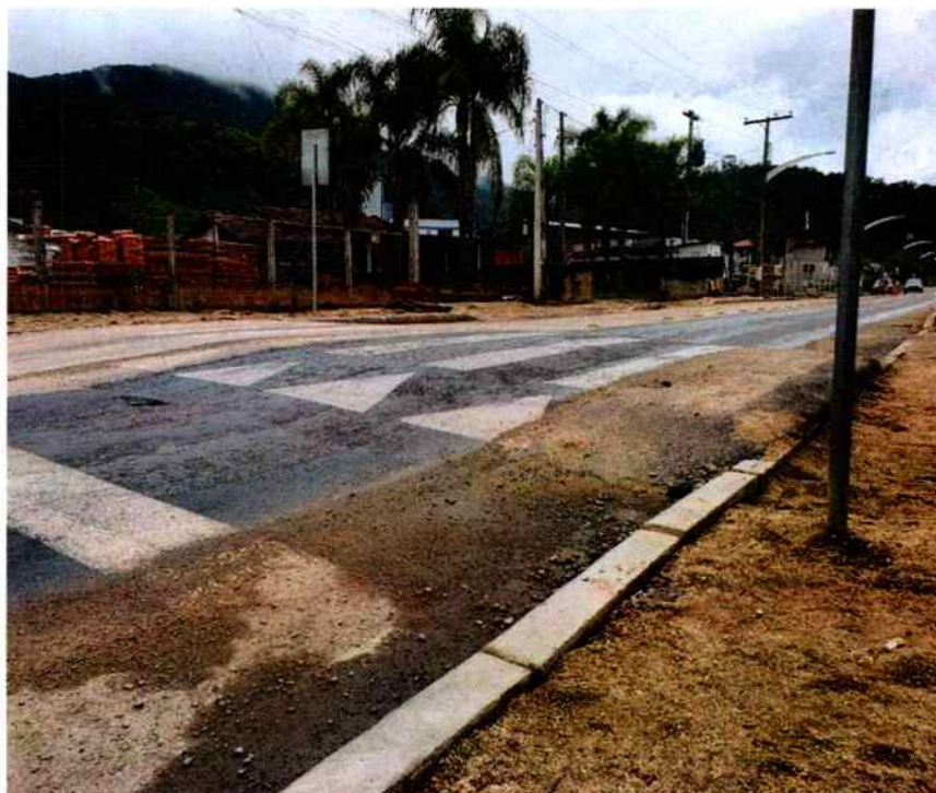
Figura 6 – Travessia elevada executada na Rua dos Imigrantes.
