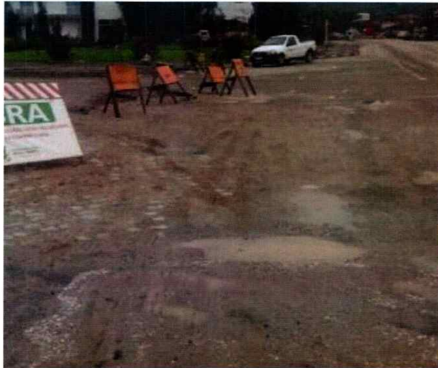
Figura 5 – Pavimentação em paralelepípedo no final da Rua Imigrantes.
