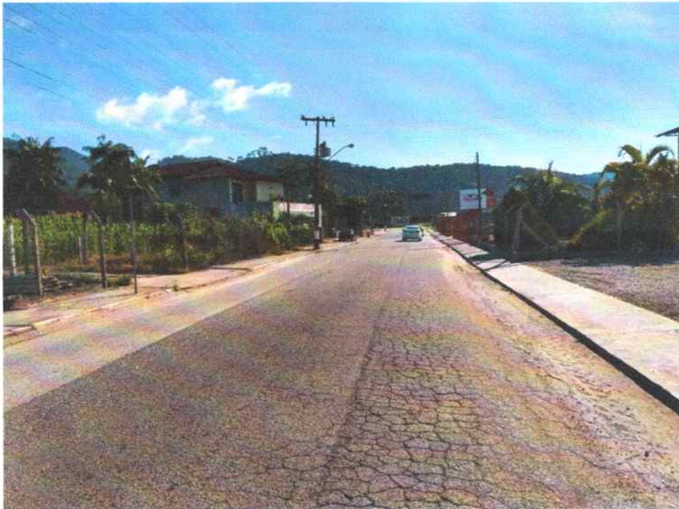
Figura 05: Situação atual da rua.
