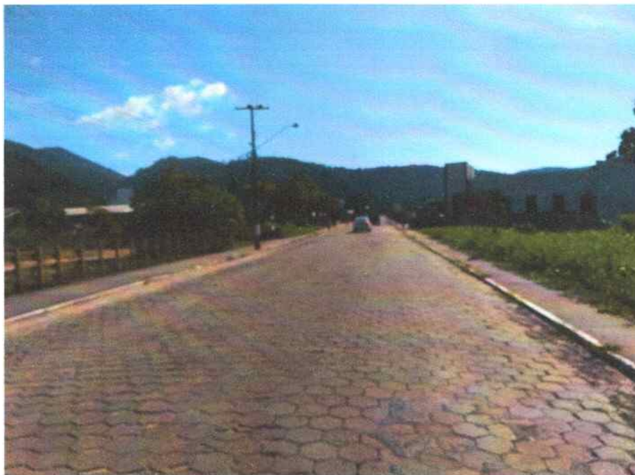
Figura 06: Situação atual da rua.
