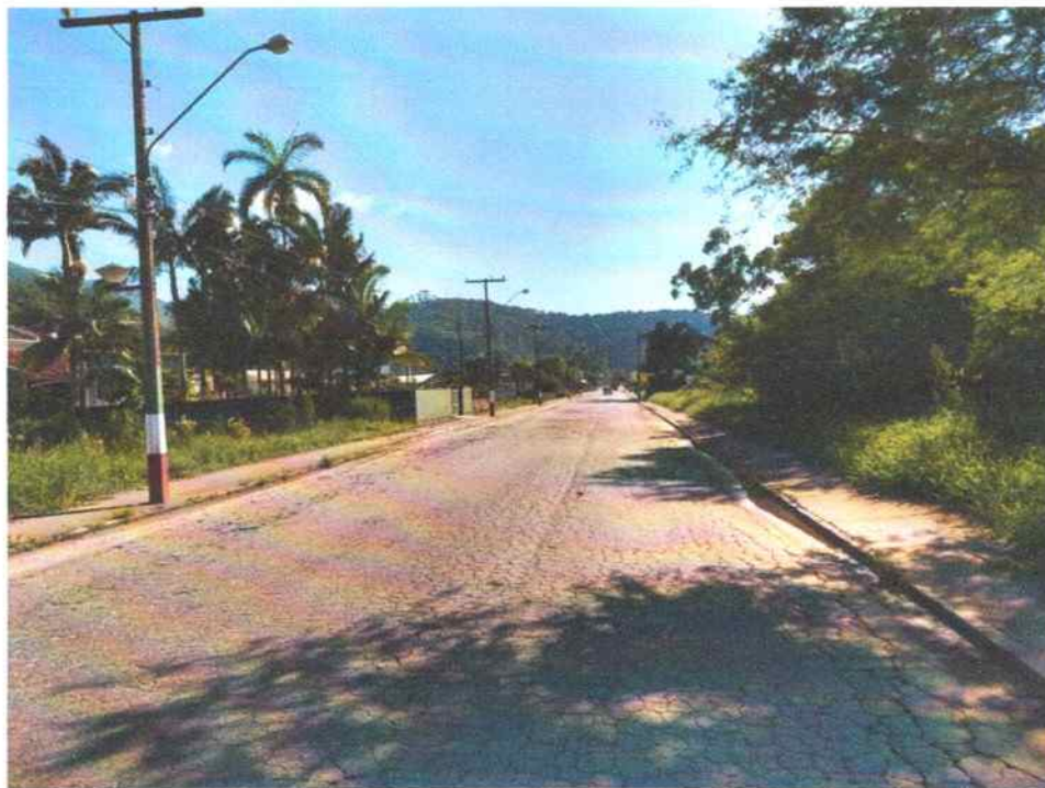
Figura 03: Situação atual da rua.
