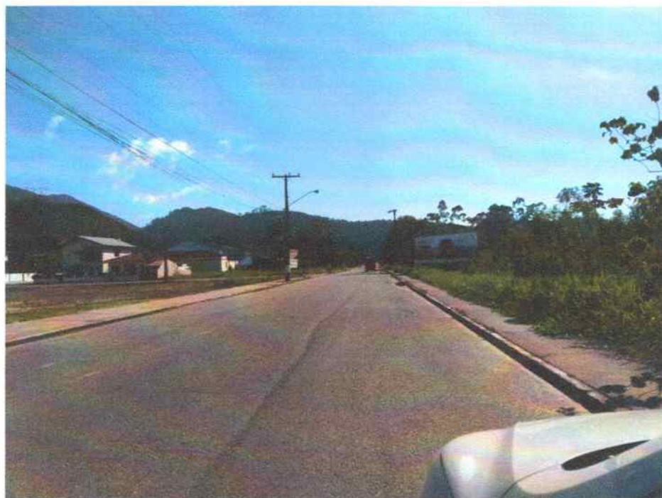
Figura 04: Situação atual da rua.
