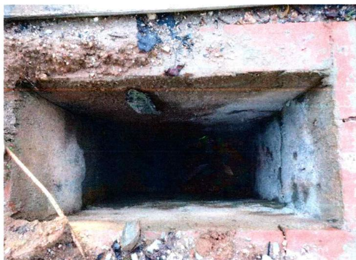
*Figura 4 Caixa Coletora executada errada*
